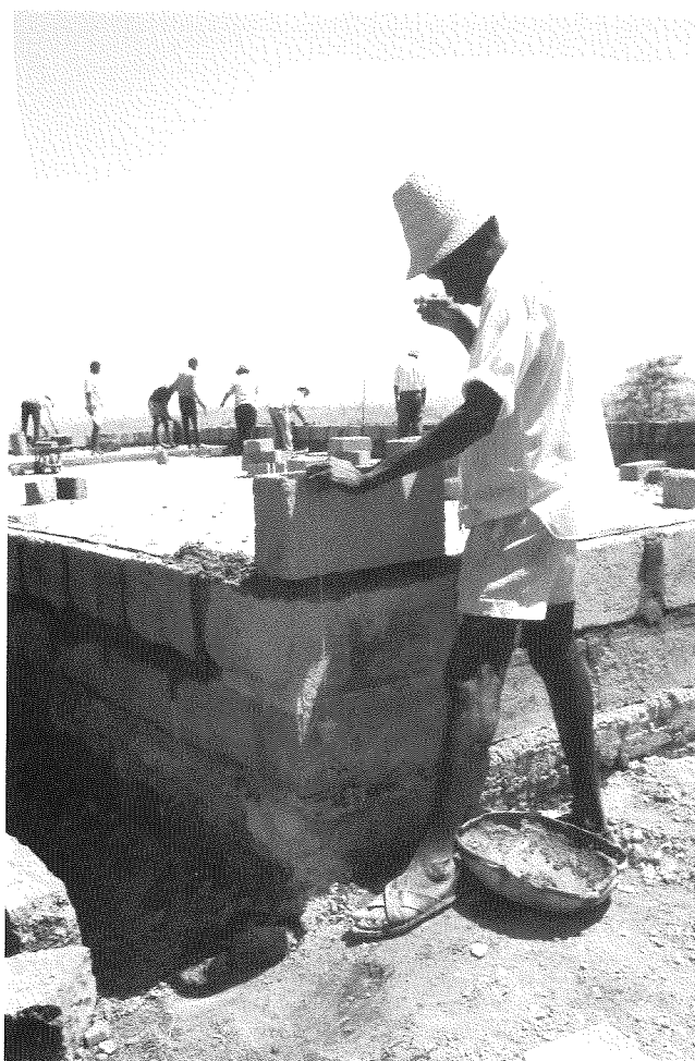
Hörnstenen till kyrkan på Atemo muras fast och konstrolleras med lodning. Om inte grunden är bra blir bygget dåligt.
